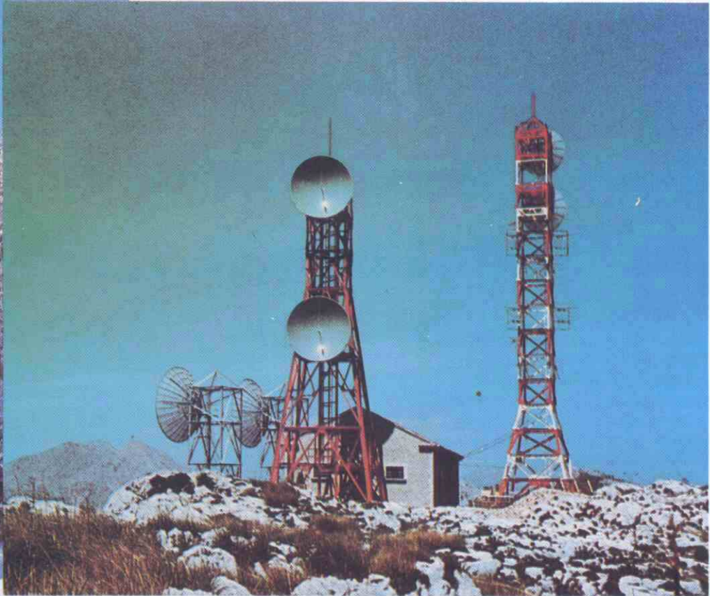
Típica instalación de una red pública. La vulnerabilidad que ofrece es evidente.
