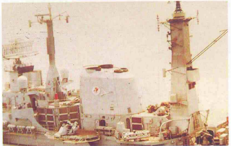
Terminal naval SCOT 1 instalado sobre el buque HMS Cardiff de la Royal British Navy. Pueden verse las dos antenas, en ubicaciones a estribor y a babor, que buscan a la vez la altura y la no interferencia sobre el resto de los sistemas de la plataforma naval. Los equipos de comunicaciones van instalados en una cabina sobre cubierta.
