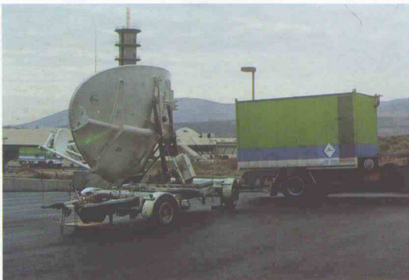
Vista de algunas de las antenas del Centro de Comunicaciones por Satélite de Guadalajara (la más próxima de 18 metros). Este centro proporciona todo tipo de servicios (telefonía, teletipo, TV, datos) a través de los distintos satélites EUTELSAT.
