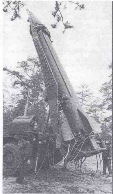
El sistema SCUD-B, de origen soviético, fue concebido inicialmente para llevar una carga nuclear, con un alcance máximo de 300 Km. y un error probable de impacto de 900 a 1.000 m.
