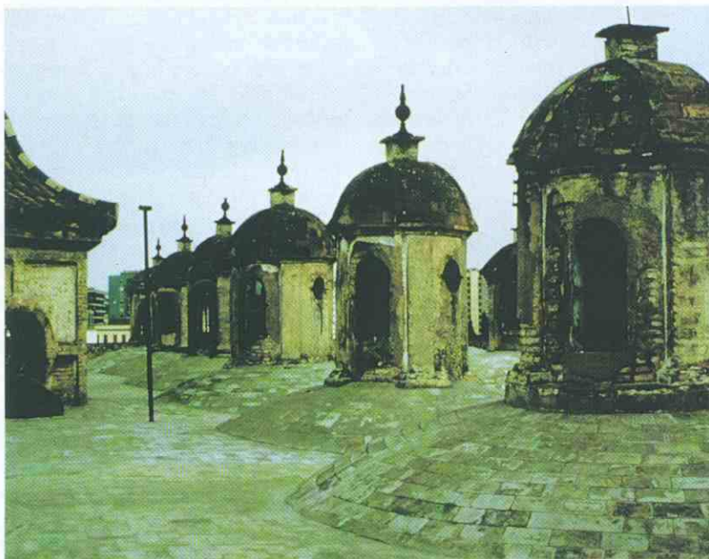
Vista del lucernario de la Fundición de Bronces.
