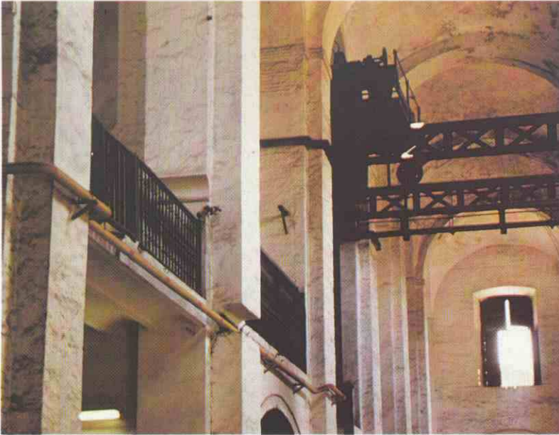
Nave principal con talleres de la Fundición de Bronces, correspondiente al lugar más elevado de la fábrica.
