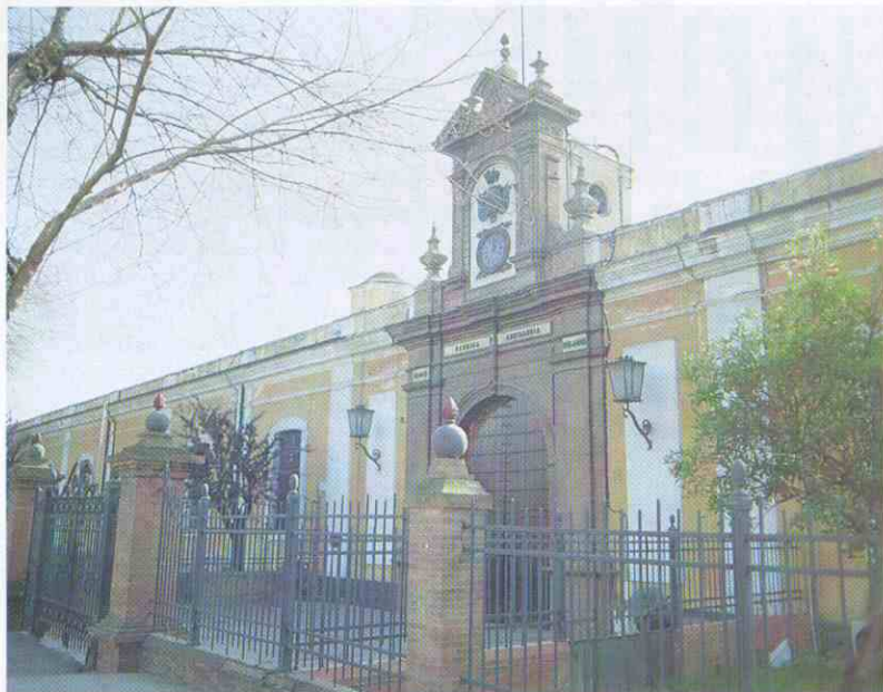
Fachada principal de la Fundición de Bronces de Sevilla.
