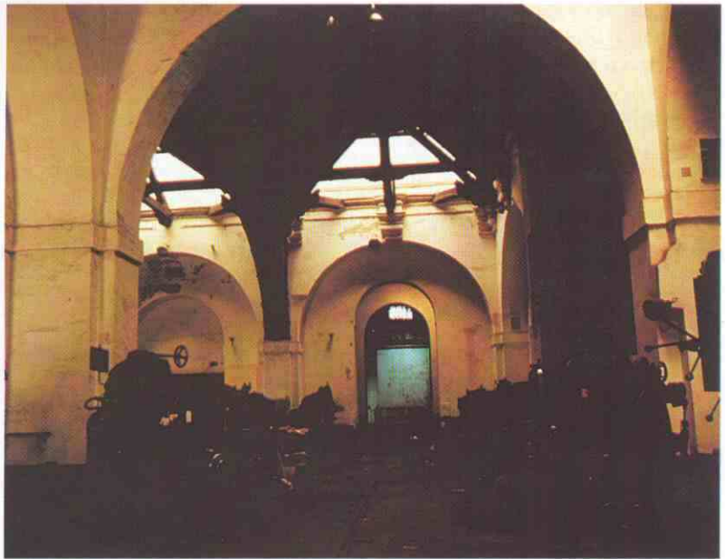
Nave de la Fundición de Bronces con las máquinas de torneear.
