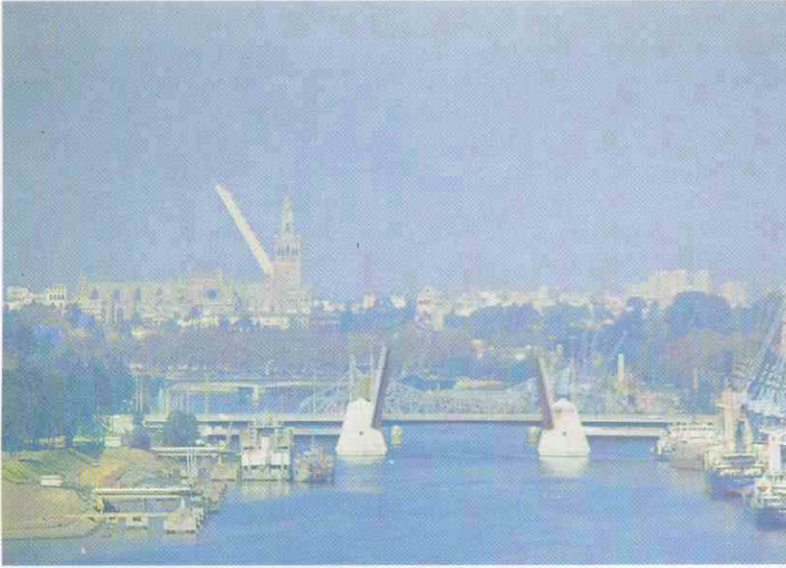
Vista de Sevilla, en el horizonte la Catedral y detrás uno de los puentes de la Expo-92.
