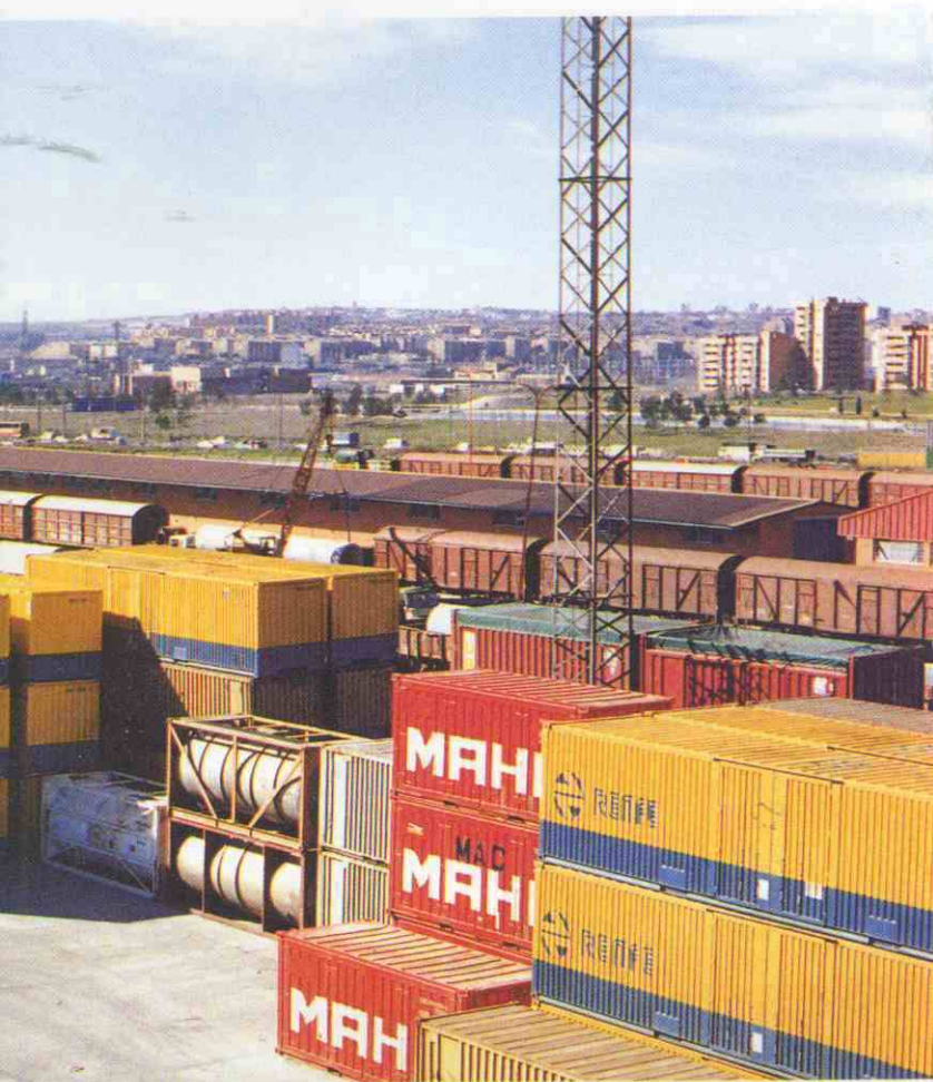
Panorámica de la estación de contenedores de Abroñigal. Pueden apreciarse contenedores de 20 y 40 pies, contenedores-cisternas y otros.
