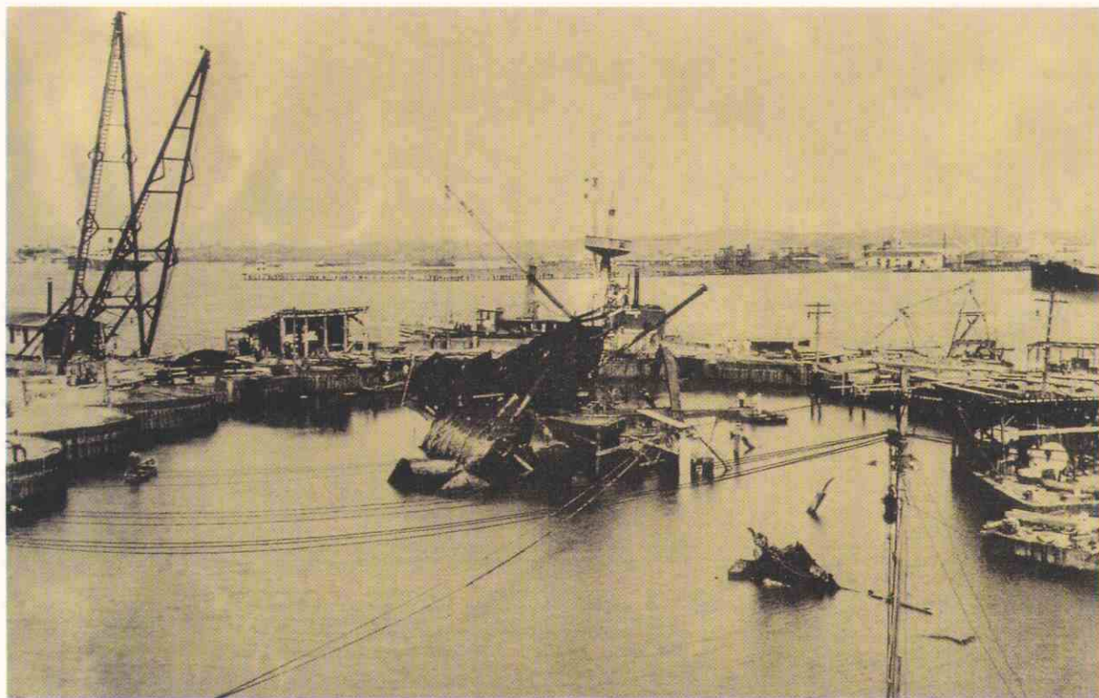
1911. Se empieza a bombear el agua de la ataguía quedando los restos al descubierto
