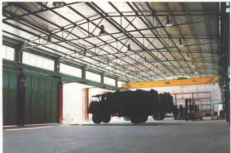
Taller con grúa-puente en la Base de San Gregorio
