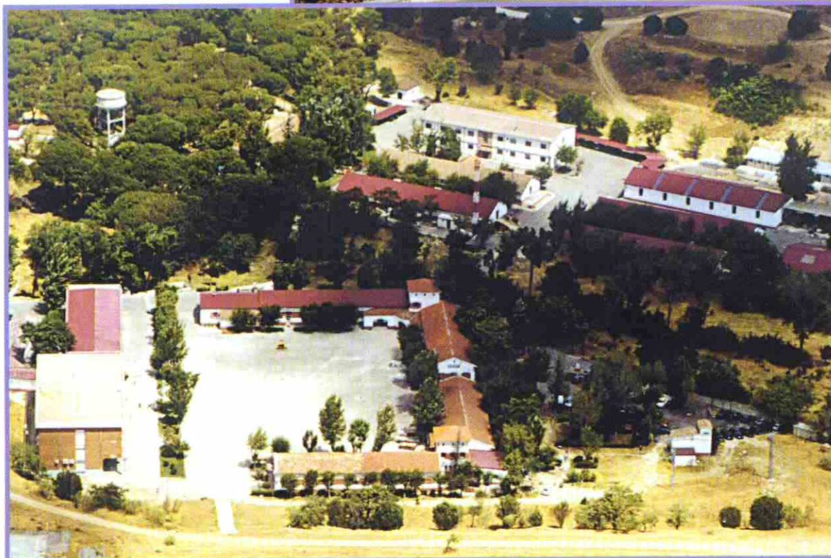
En diciembre de 1997, al aprobarse la nueva estructura de mandos de la OTAN, España ofrece las instalaciones donde se había ubicado la AGASAN en Retamares (Pozuelo) como sede provisional para el CG. Subregional Sudoeste
