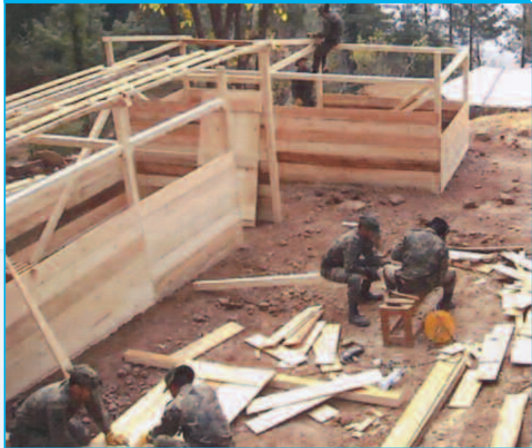
Ingenieros trabajando en la construcción de refugios
