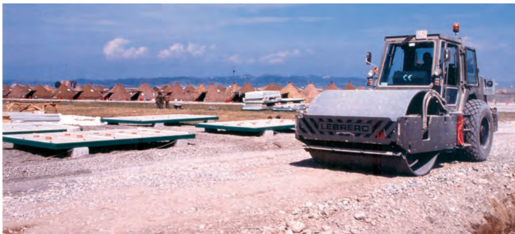
Trabajos previos construcción de campamento, Albania
