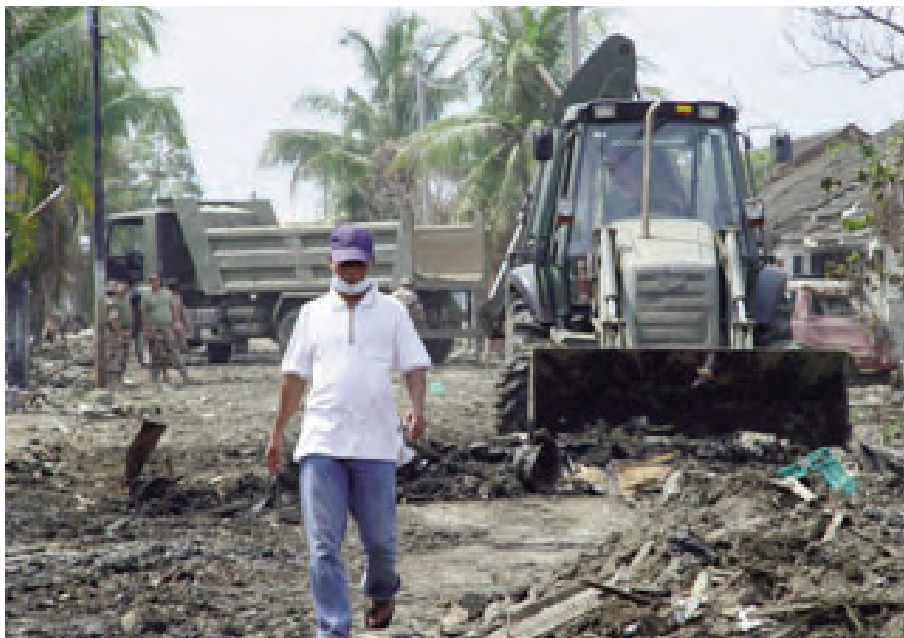
Limpieza de escombros. Indonesia.
