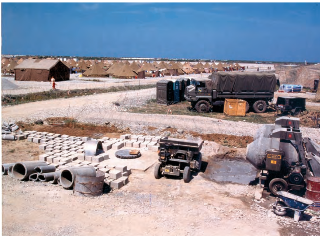
Trabajos de construcción de campamento en Albania
