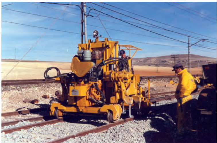
Trabajos de ferrocarriles
