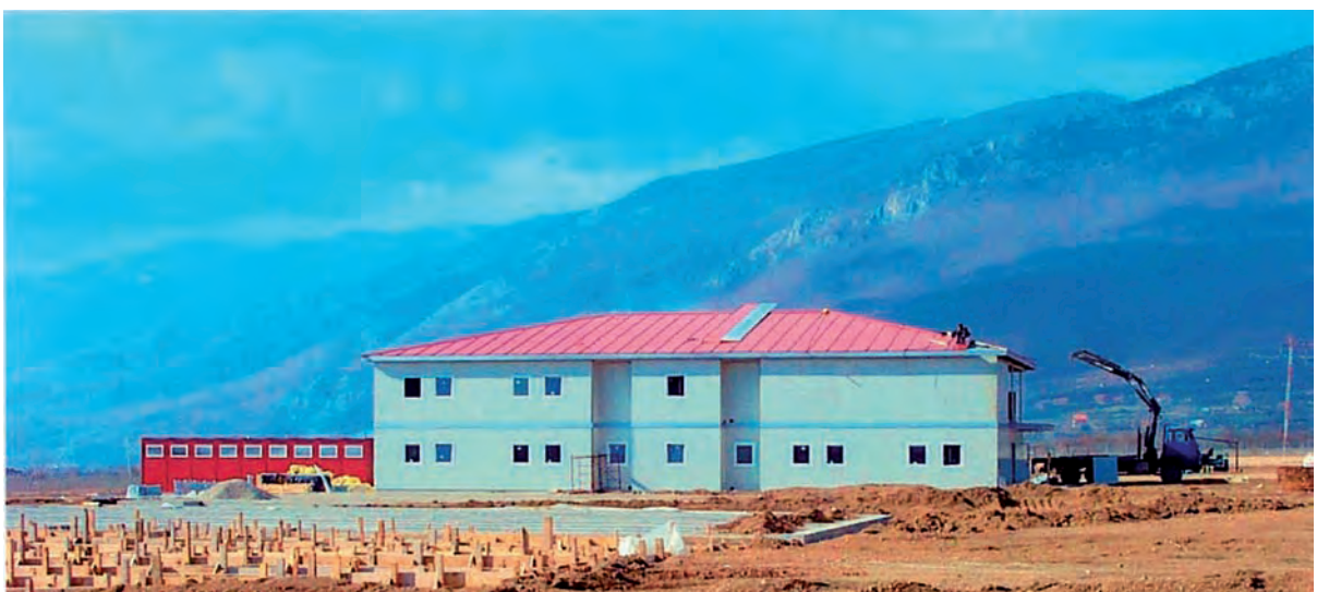
Construcción de la base de ISTOK
