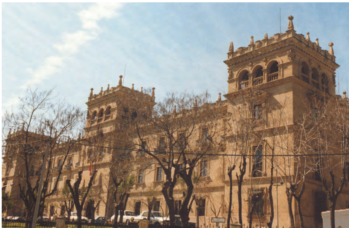
Acuartelamiento General Arroquia, Salamanca
