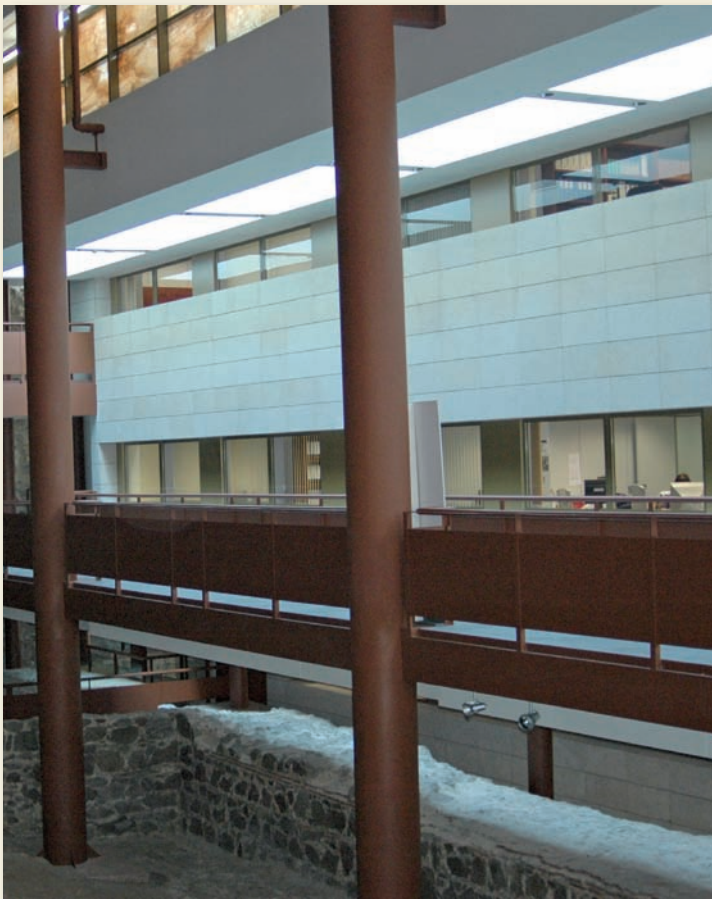
Vista de las instalaciones administrativas
