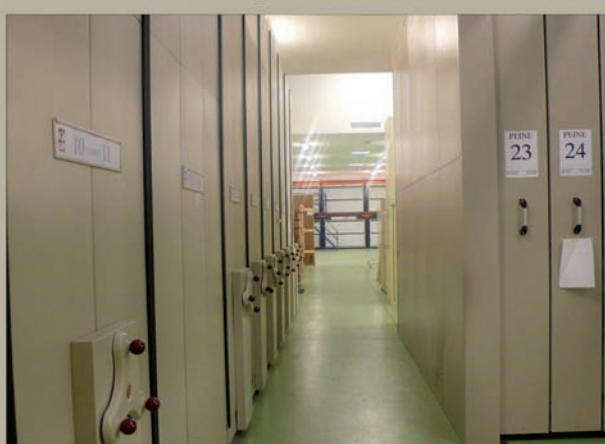
Descarga e instalación
