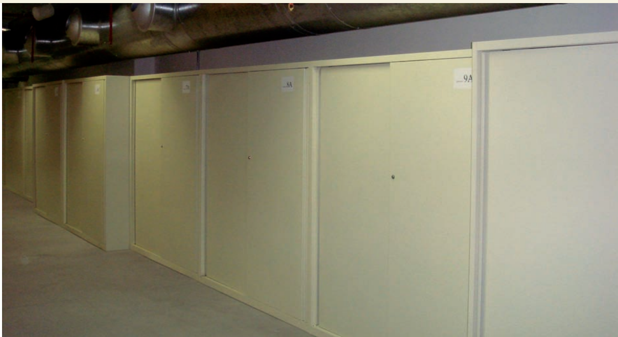
Armarios para uniformes. Almacén E.
