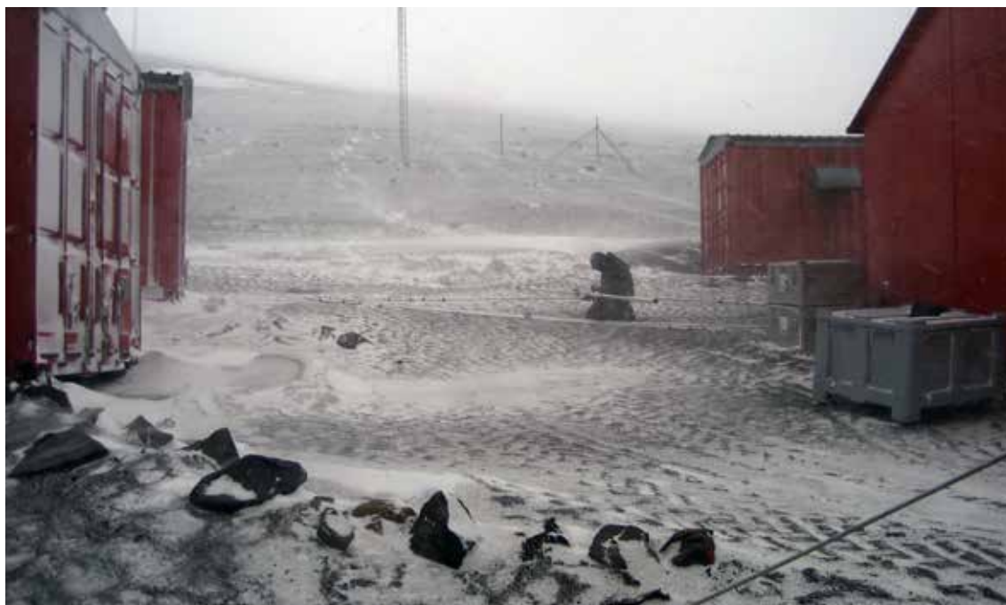
Labores de reparación y mantenimiento de material de telecomunicaciones en la Base Antártica Gabriel de Castilla
