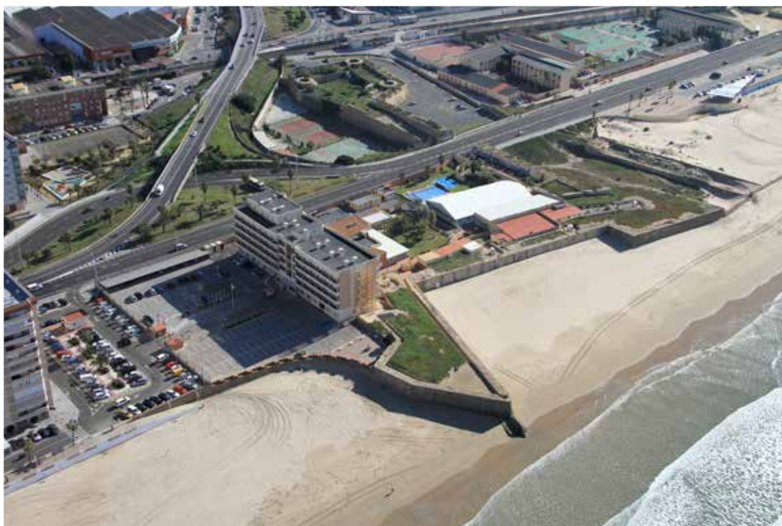
Vista aérea de la Residencia de Acción Social de Descanso La Cortadura de Cádiz
