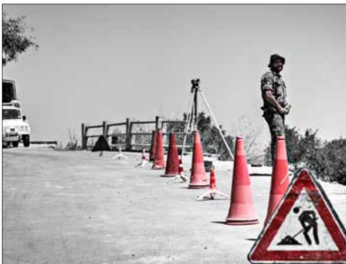
Mantenimiento de carreteras
