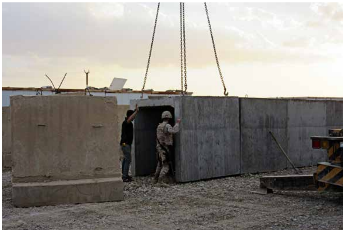
Construcción de refugios
