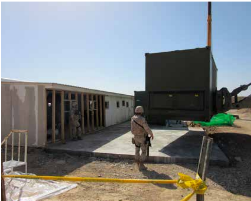
Instalación de cocinas
