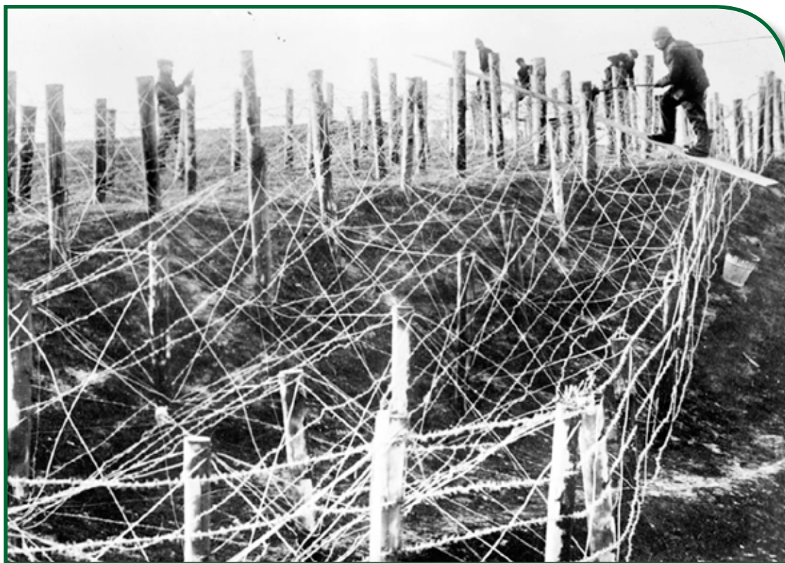
Ingenieros alemanes reparando alambradas
