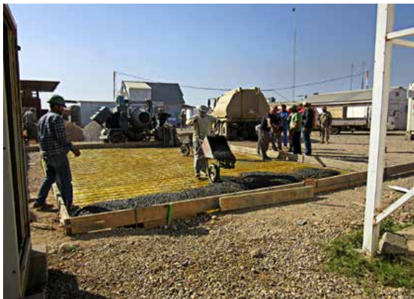
Trabajos ejecutados por contrata civil y control de ejecución por parte de la unidad de ingenieros (UING AD)
