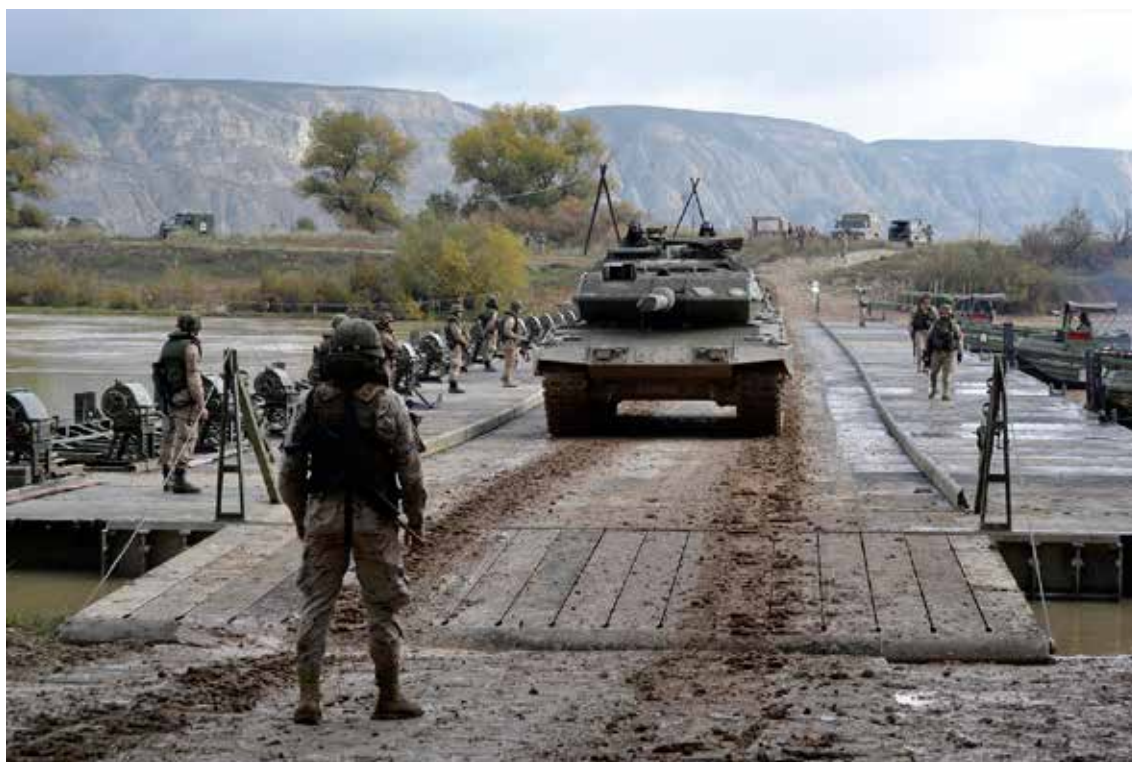
Personal de zapadores tiende un puente, para el paso de un carro Leopard, sobre el río Ebro
