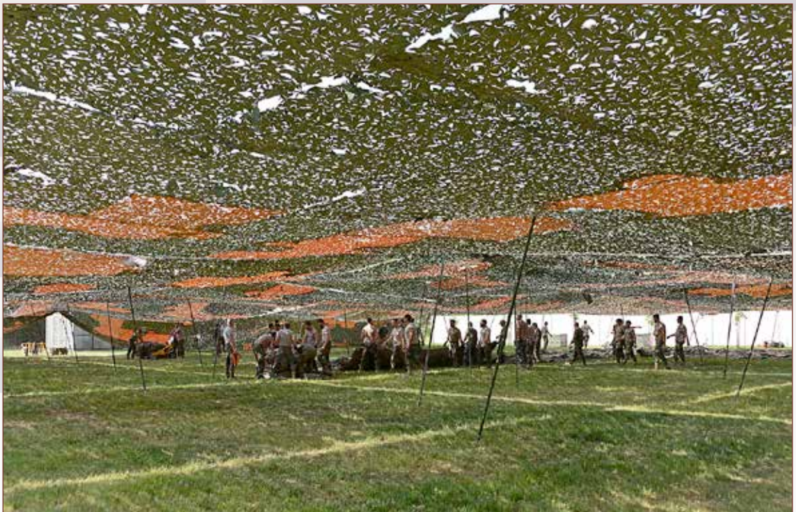
Montaje del puesto de mando (PC)
