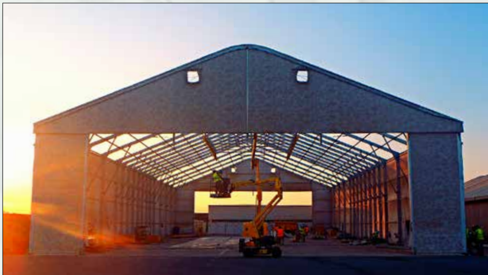
Construcción de hangares. La idea de implantación de unidades polivalentes actuaría como un factor multiplicador de capacidades
