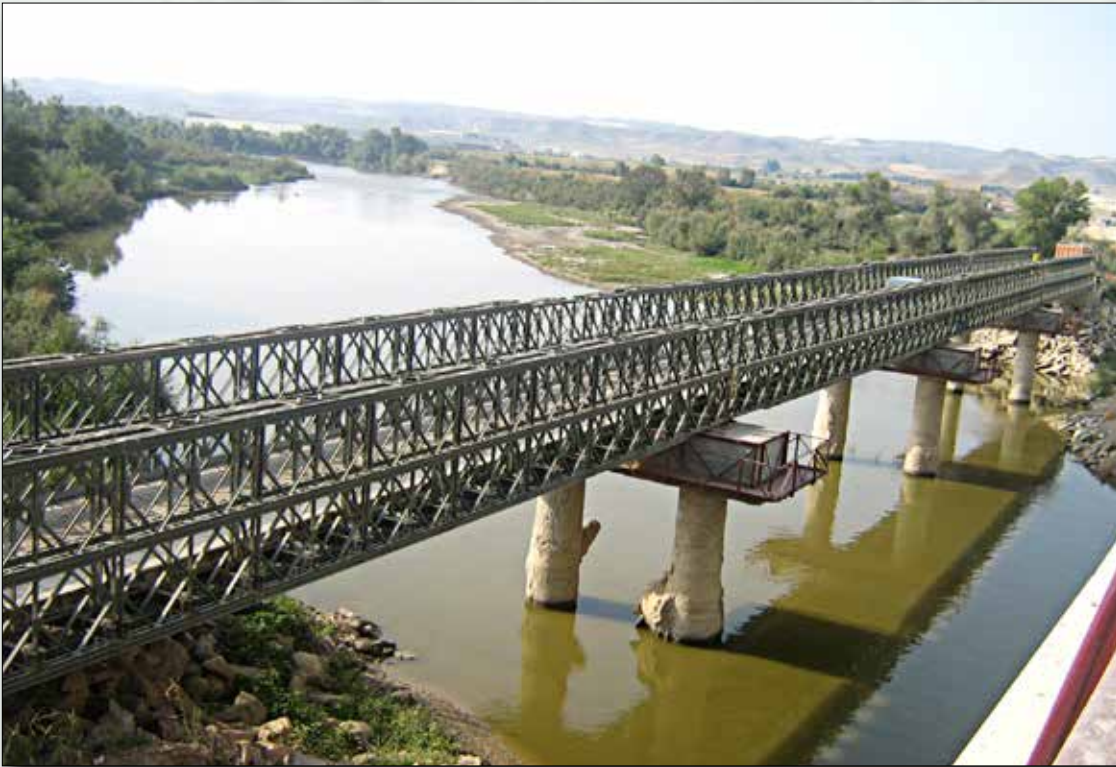
Puente logístico MABEY. La instrucción con estos materiales tiene muchas limitaciones por falta de créditos y equipos
