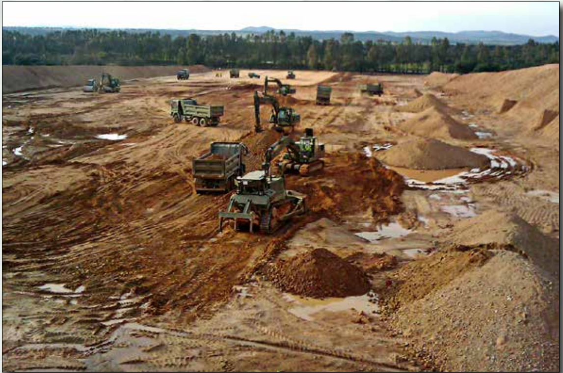
Movimiento de tierras. Es muy a tener en cuenta la huella logística en el planeamiento de una operación
