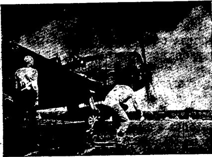
Fig. 5.—La presencia del enemigo ha sido señalada. Inmediatamente, a bordo de los portaaviones da comienzo la maniobra de despegue, cuyo momento culminante vemos en esta fotografía: se da la salida al primer avión. Nótese el depósito de gasolina supletorio, que lleva entre las ruedas, para aumentar el radio de acción y (a la izquierda de la foto) los «flaps», que lleva bajados para despegar.
