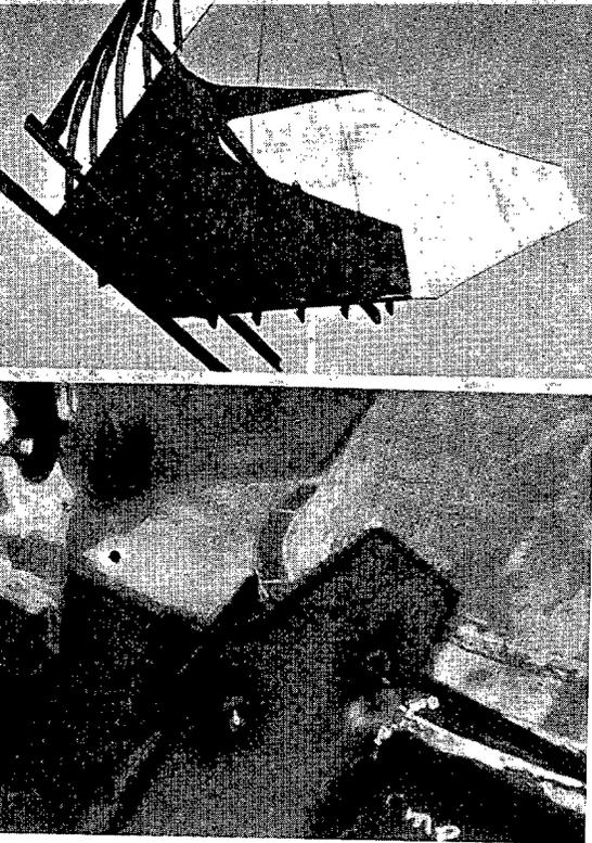
Hydrex, de Amberes, que consistió en la construcción de la parte del bulbo del buque que había sido afectada por la colisión y la posterior colocación de la misma por hombres rana, que procedieron a la soldadura bajo el agua de los bordes de la pieza.
