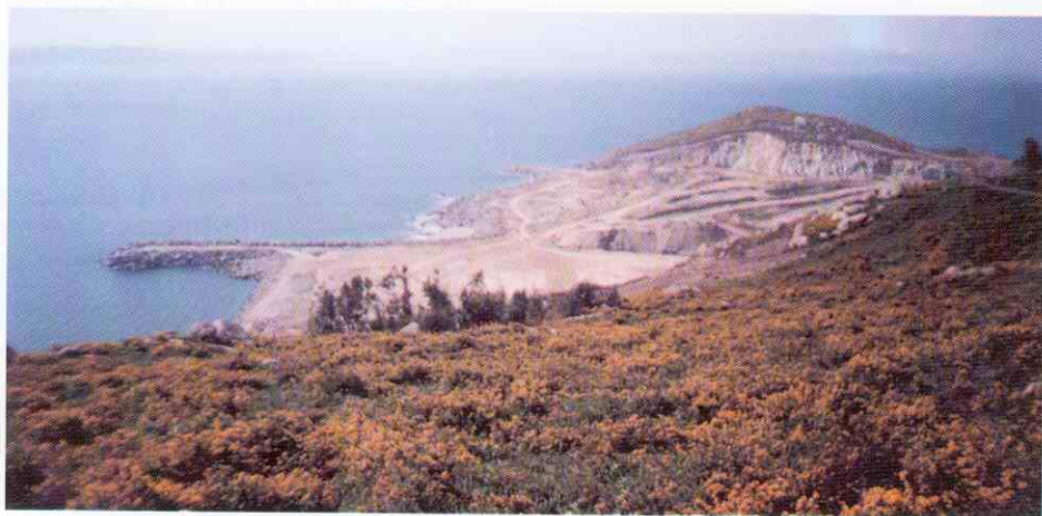
Construcción del puerto exterior de Ferrol. (Foto: A. Pintos Pintos).
