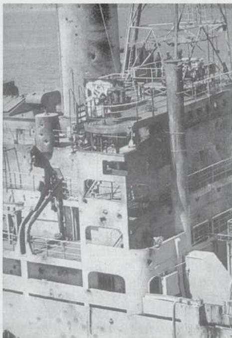
Zona del puente del *Liberty* tras el ataque. Aún a cierta distancia pueden apreciarse buen número de orificios en la superestructura, así como una docena de impactos por debajo de la cubierta principal que no han perforado la plancha. La escoba del alerón de Er. indica que ya se está poniendo la casa en orden. (Foto de origen desconocido, probablemente obtenida desde un helicóptero de la Marina norteamericana).
