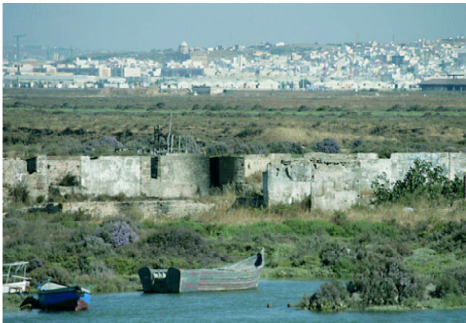
Baluarte de San Pedro, del conjunto de fortificaciones de la cabeza del puente de Suazo. Artillado con cuatro cañones de a 24, cinco cañones de a 16 y tres obuses de a ocho. Al fondo, Chiclana de la Frontera.
