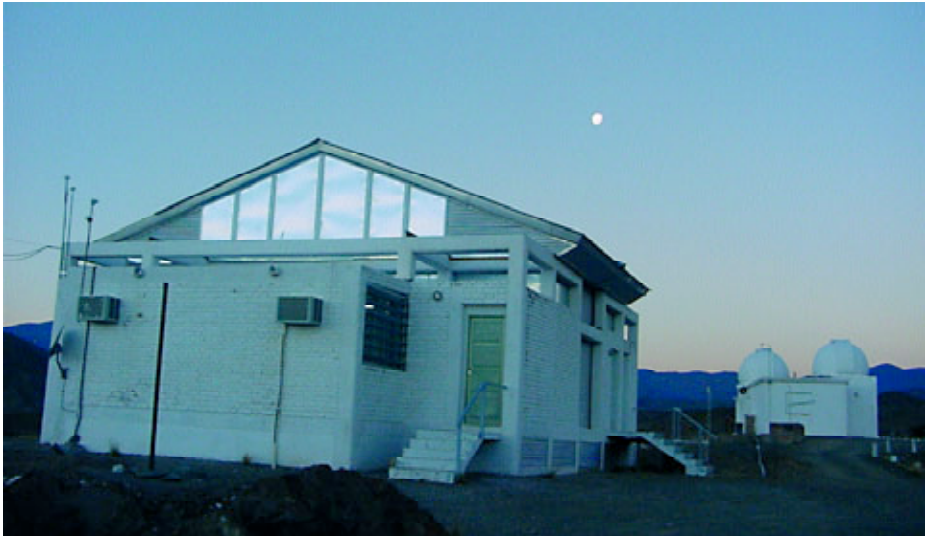
Edificio del CMASF.
