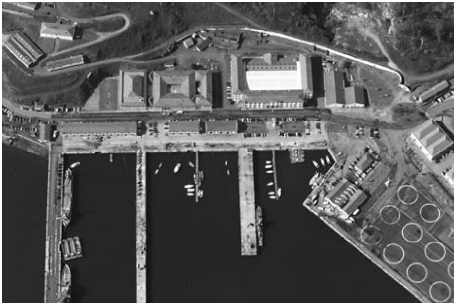
Vista aérea de la Escuela de Especialidades Fundamentales de La Graña-Ferrol.
