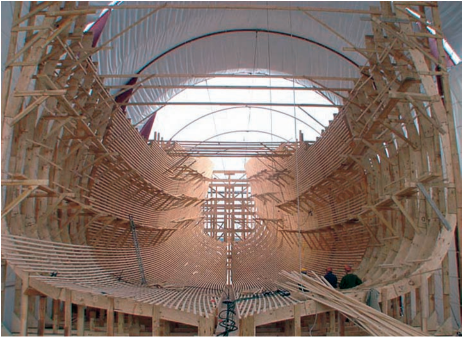
El armazón prácticamente terminado en el mes de noviembre.
