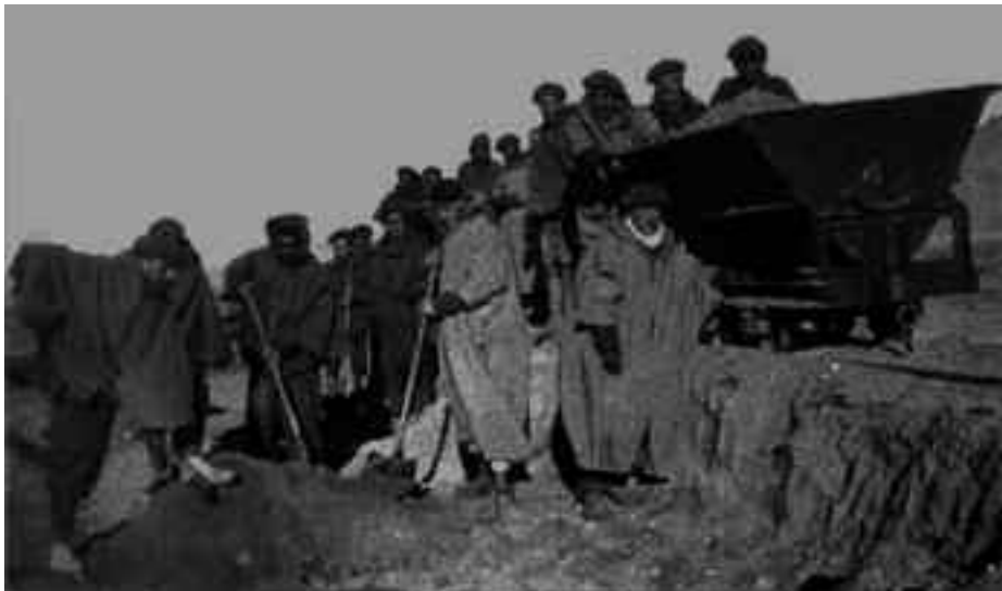
Construcción del ferrocarril Transahariano.
