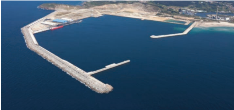
Vista aérea de Punta Langosteira. (Foto: web Autoridad Portuaria de A Coruña).
