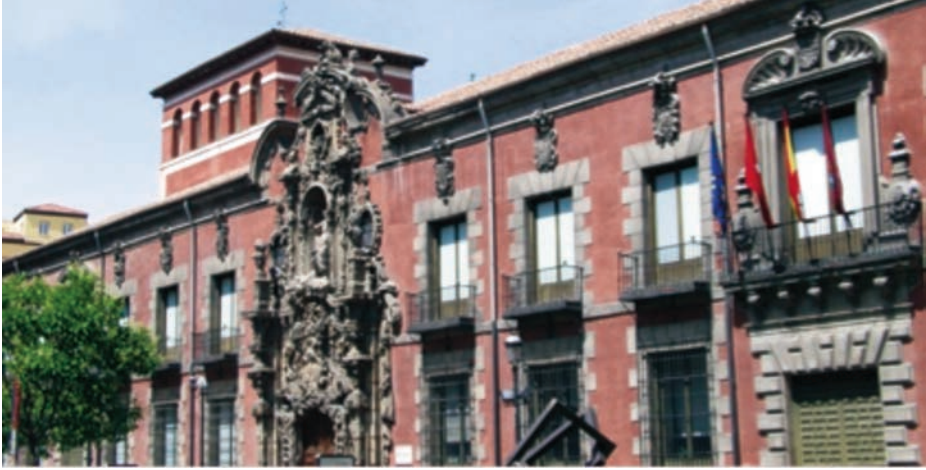
Vista de la fachada con la portada barroca. (Foto: OHCN).
