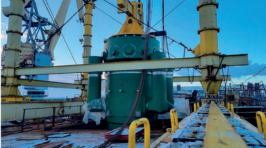
Instalación de reactores nucleares en el rompehielos Chukotka en San Petersburgo. (Fotografía facilitada por Luis Vicente Pérez Gil)
