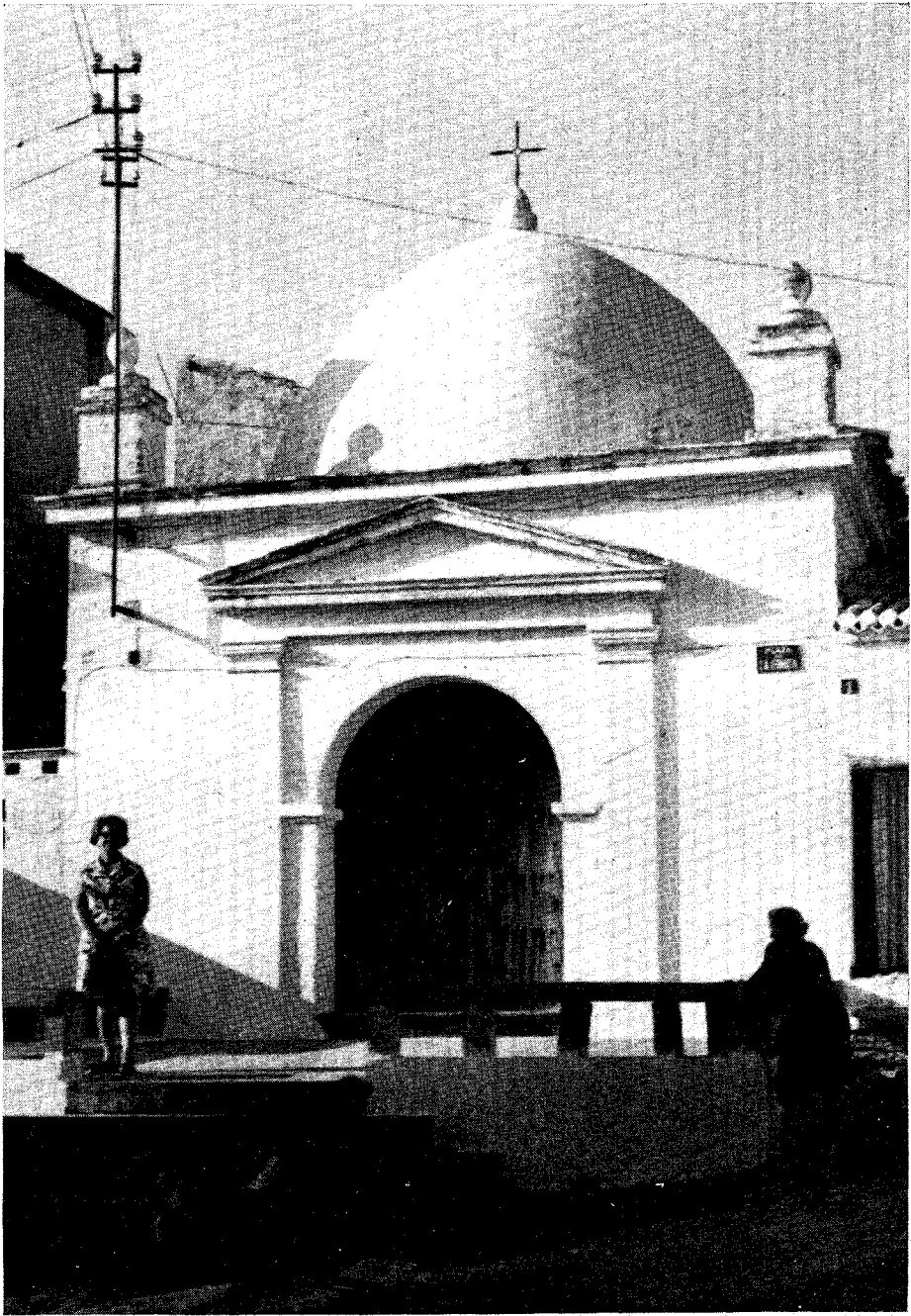
Ermita de San Sebastián, en la barriada de este nombre, antigua zaúia árabe. Foto del autor.
