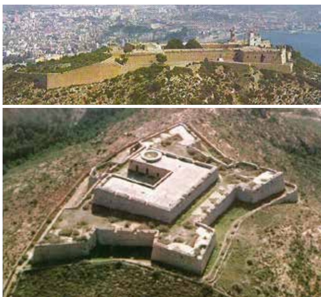
Figuras 7 y 8. Vistas aéreas de los castillos de Galeras (arriba) y de La Atalaya (abajo), construidos entre los años 1773 y 1777, y que, junto con el castillo de San Julián, constituían las principales obras de defensa militar del recinto exterior de la plaza fuerte de Cartagena. Fotografías de la obra La Artillería en la Defensa de Cartagena y su Base Naval , de Federico Santaella (Editorial Aglaya. Cartagena. 2001)
