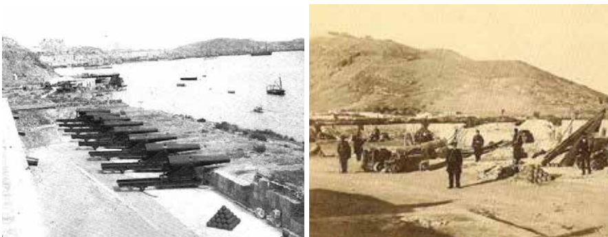
Figuras 12 y 13. A la izquierda, Batería del Apostolado, en El Espalmador (Cartagena), artillada con cañones Barrios calibre 28 cm. Y, a la derecha, Baluarte de Cantarranas, en el Frente Este del sistema defensivo de la muralla de la ciudad de Cartagena
