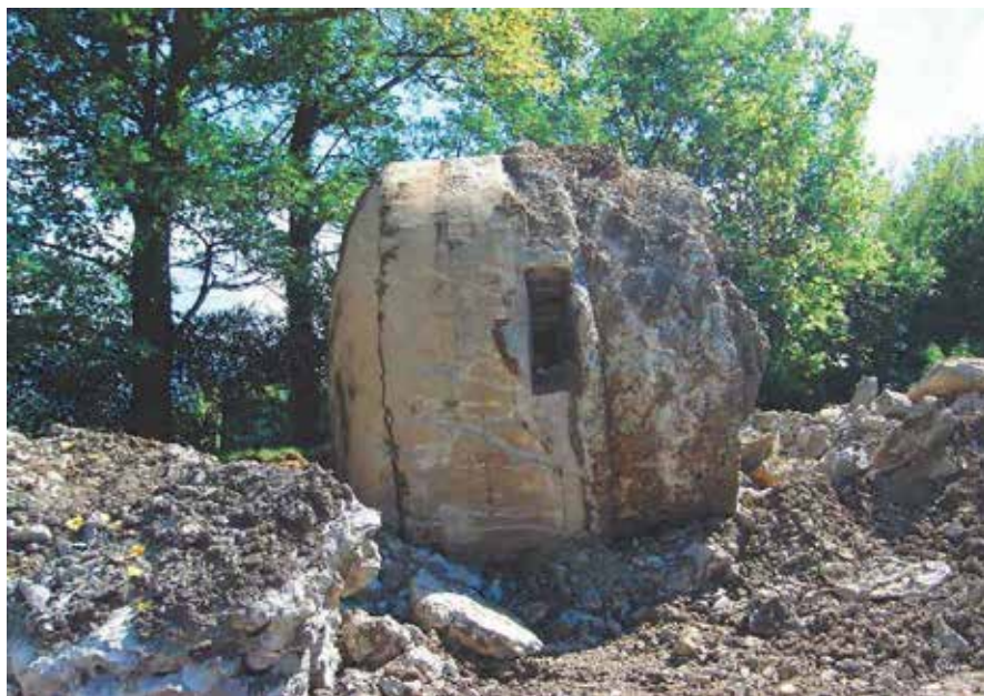
Ilustración 17. Demolición de un bunker, año 2006 (imagen del autor)
