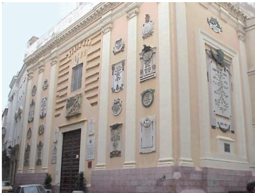
Fig. 3. Fachada de la Iglesia Oratorio de San Felipe Neri con la citada lápida
