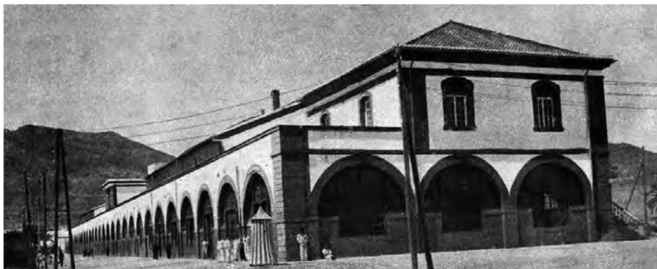
Base de submarinos en 1920. El edificio de la imagen es la antigua sala de gálibos, en la que se estaba acometiendo una reforma para adaptarla a sus nuevos cometidos docentes
