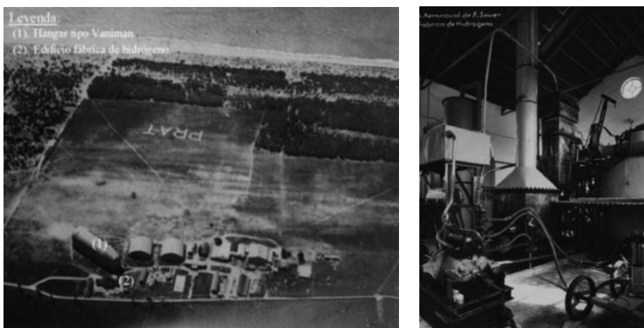
Imagen 13. Panorámica del aeródromo de El Prat, también conocido como «Campo de los Marinos». En la misma se indican: (1) hangar tipo Vaniman, y (2) edificio de la «fábrica de hidrógeno». En la fecha de la fotografía también era el «Aeropuerto Provisional de Barcelona», según la Ley de Aeródromos y Aeropuertos de junio de 1927, con la señal en el suelo identificativa del campo de vuelo ( Fuente: Moragas Bringué, 1928). Imagen 14. Interior del edificio donde se encontraba la fábrica de hidrógeno semifija (transportable) al silicol, instalada en San Javier. (Fuente: Archivo General Militar de Madrid, IHCM, F-12521)
