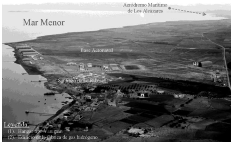
Imagen 15. Base aeronaval del Mar Menor, que pasó a denominarse de San Javier (DO 28, 1930). (1) el hangar tipo Vaniman, y (2) el edificio de nueva construcción para la «fábrica de hidrógeno». (Fuente: AMSJ, fondos Miguel Ferrer, s.f.)
