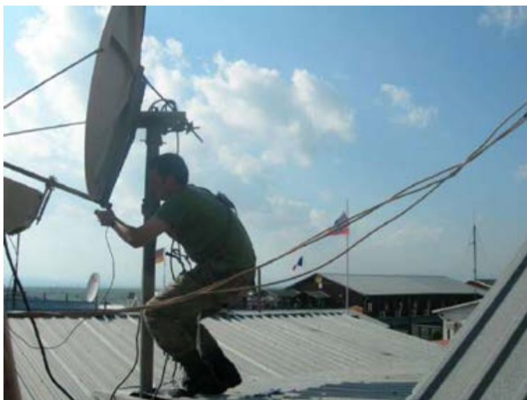
Realizando tareas de mantenimiento en Mostar Aeropuerto
