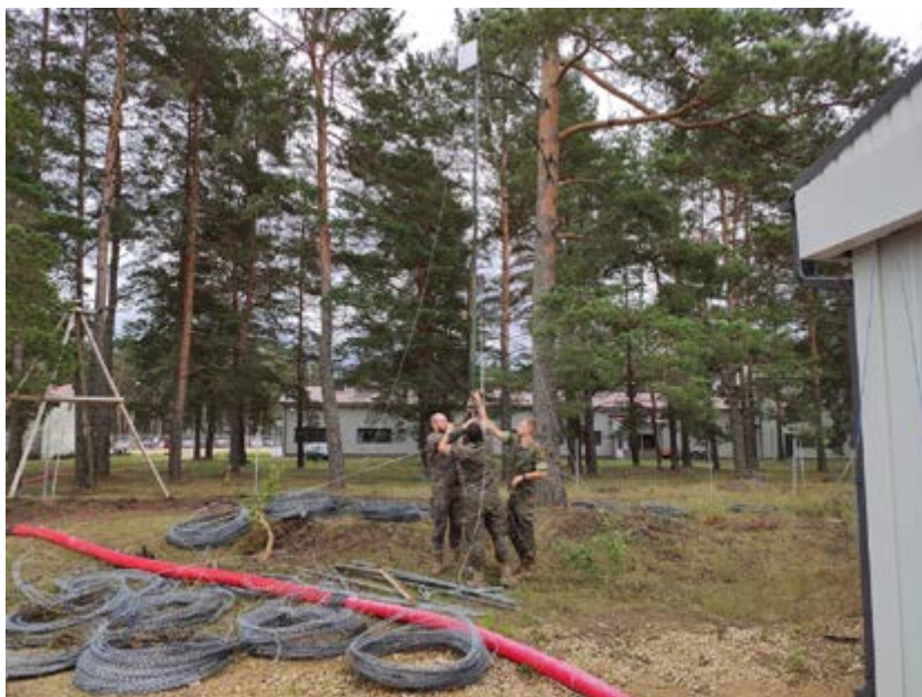
Desmontando enlace E1
