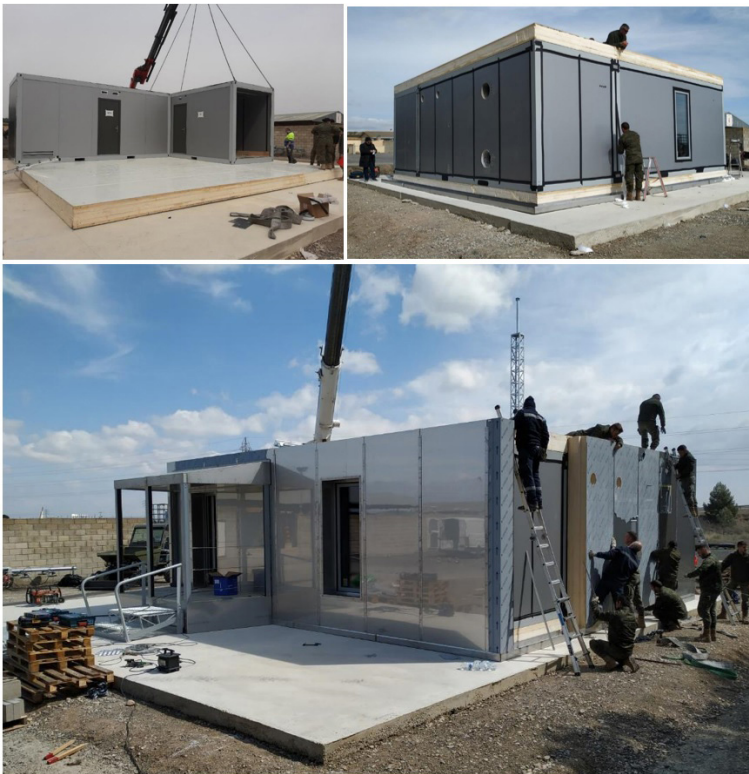
Imagen 5. Diferentes fases de montaje del prototipo en la base San Jorge. Fuente: los autores
